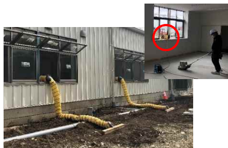
送風機を稼働し、埃を外部へ排出
