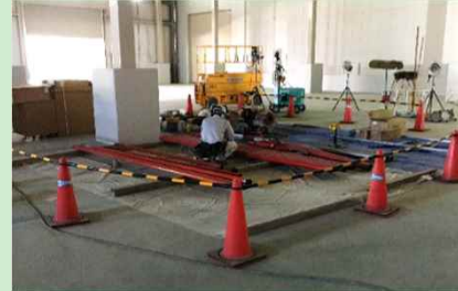
工事エリアの区画を設定して作業
